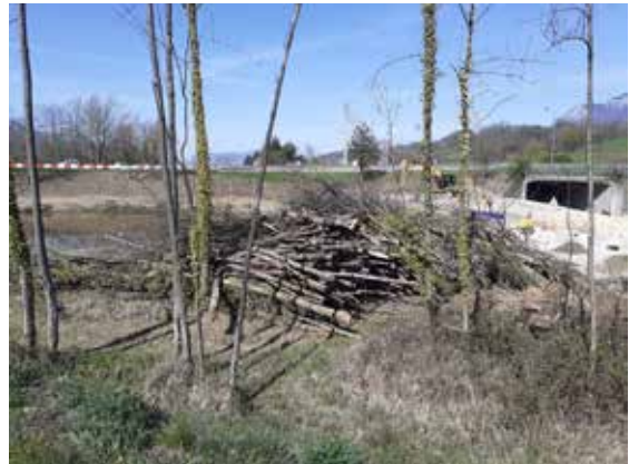
> Bois humide détruit et mare à demi remblayée dans la bretelle sud © Jean-Claude Madelon
