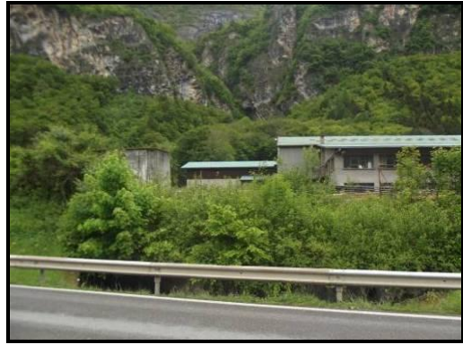
Point de passage du cours d'eau, sous la route (crédit photo : C. Gilles).
