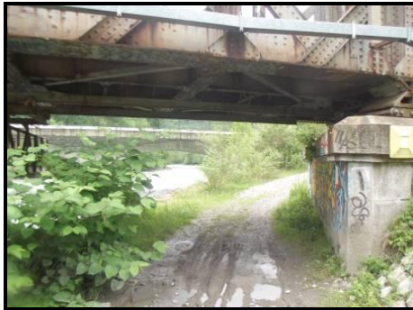
Passage sous le pont ferroviaire, en rive gauche (crédit photo : C. Gilles).
