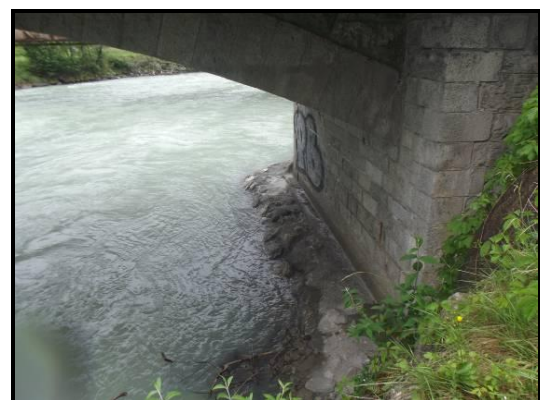
En rive droite, la banquette est inaccessible (crédit photo : C. Gilles).
