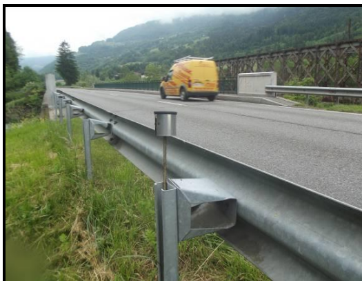
Réflecteur au niveau du pont de la D125 (crédit photo : C. Gilles).
