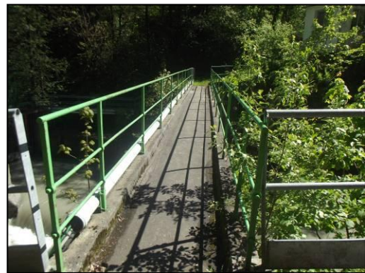
La passerelle du barrage EDF (crédit photo : C. Gilles).
