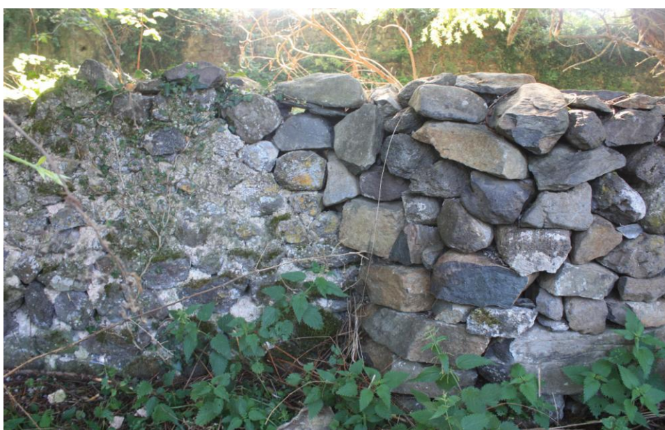
Figure 2.7 - Premier muret de délimitation construit, 1m de hauteur et 70 cm de largeur. Réalisé dans le cadre d'un chantier-stage encadré par les muraillers FC Januel et L Jalade. Le muret a été continué sur un muret déjà construit avec du liant - Juillet 2018
