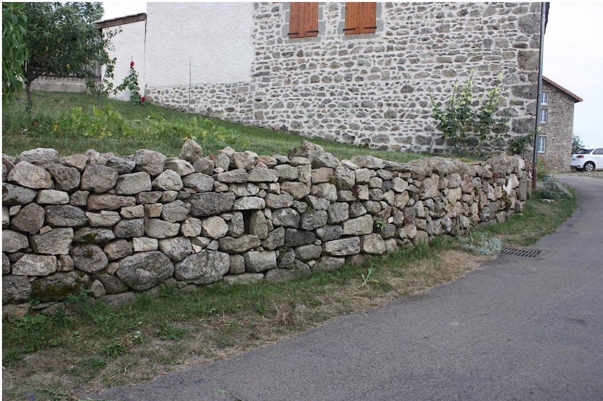
Figure 1.8- Muret de pierre sèche restauré par la Société d'Histoire de Craponne. On peut y voir à l'intérieur des giroflées des murailles et du sedum – Août 2018
