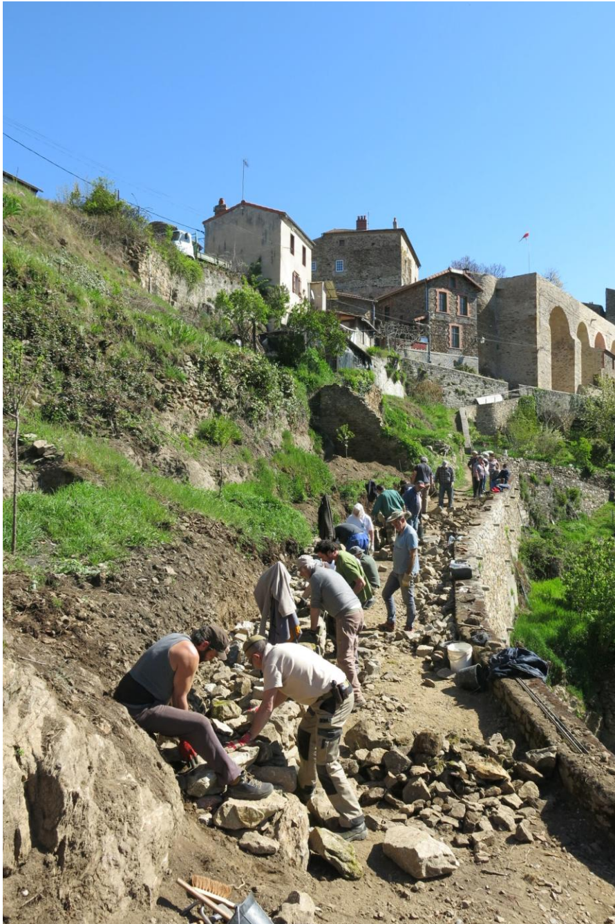
Figure 1.5 - Travail en équipe pour la reconstruction du muret du chemin de ronde de la commune d’Auzon. Source : PNR Livradois-Forez.
