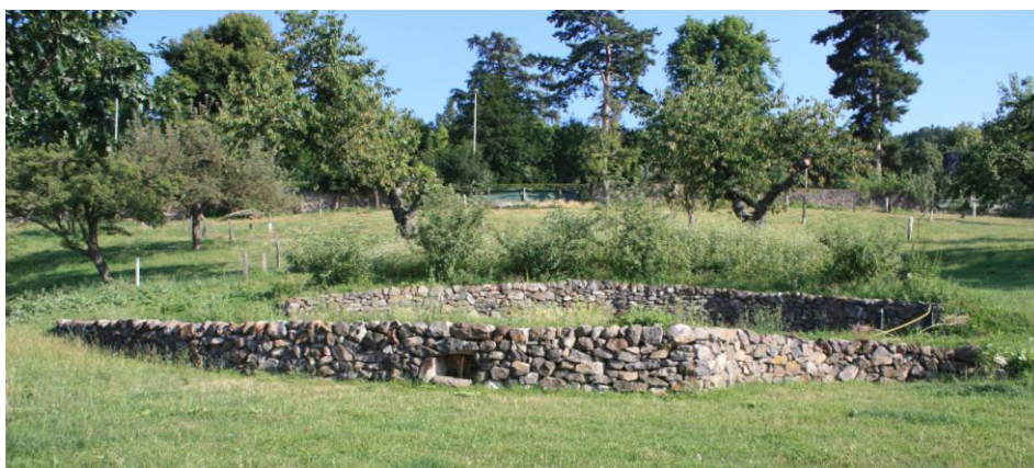
Figure 2.8 - Murets de soutènement en arrondis, réalisés dans le cadre d'un chantier-stage encadré par un murailler professionnel - Juillet 2018
