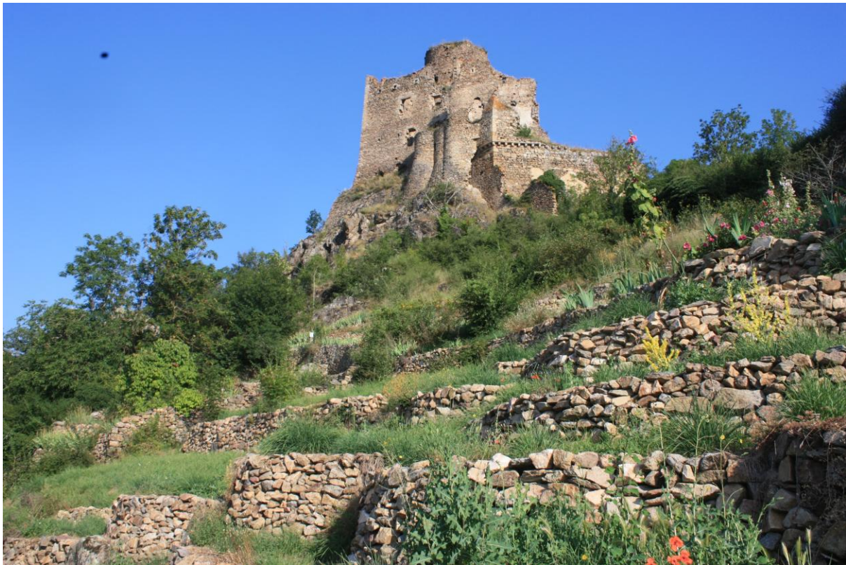
Figure 1.1 - Les terrasses en pierres sèches du château de Léotoing - Juillet 2018
