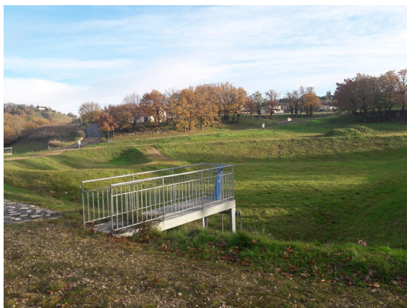
> Secteur inondable – Bassin de rétention – Saint-Céré (Lot)
