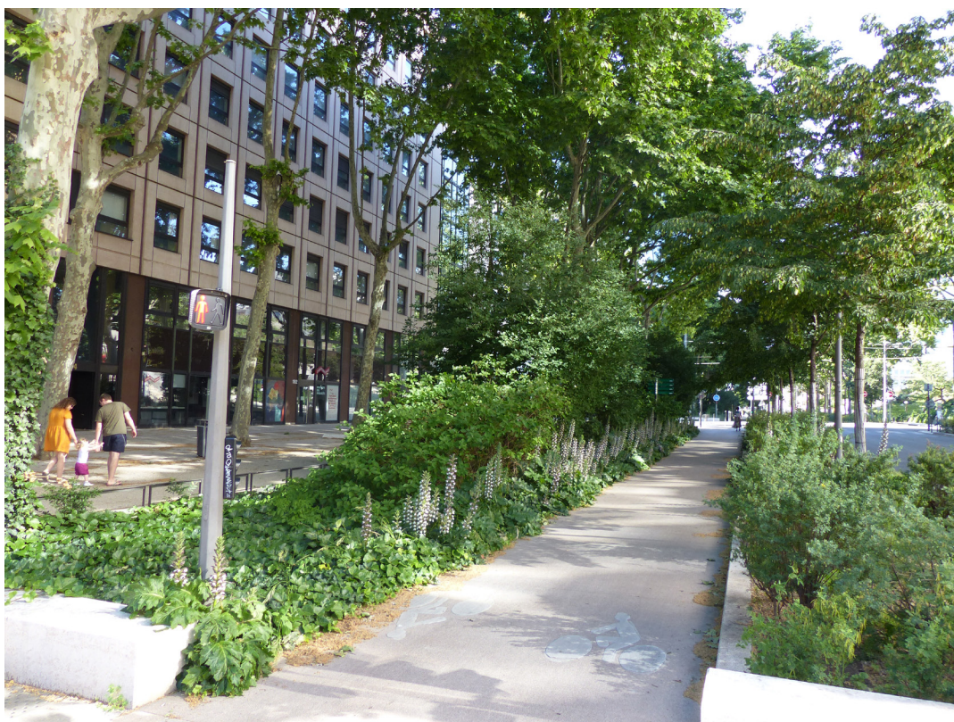
> Noues sur la rue Garibaldi – Lyon
