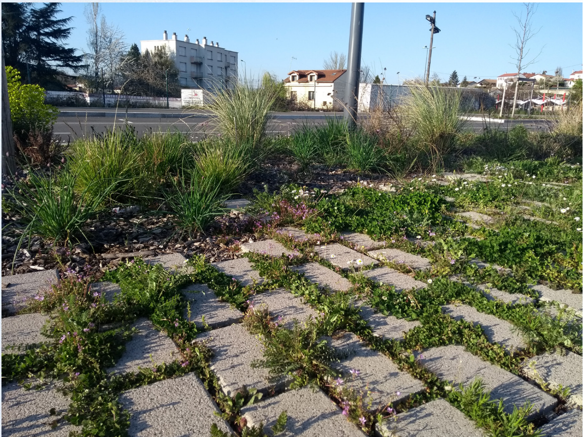
> Pavés végétalisés - Saint-Etienne
