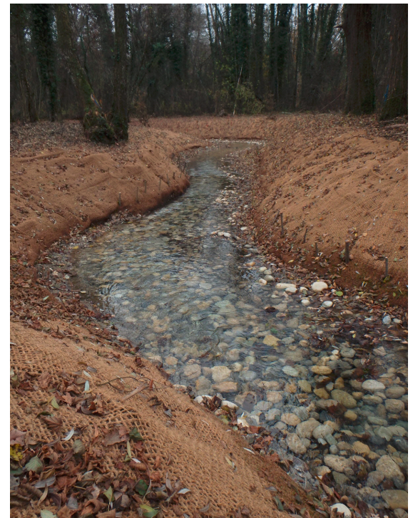
Travaux de réaménagement des berges sur le Lion (©leprogres.fr)
