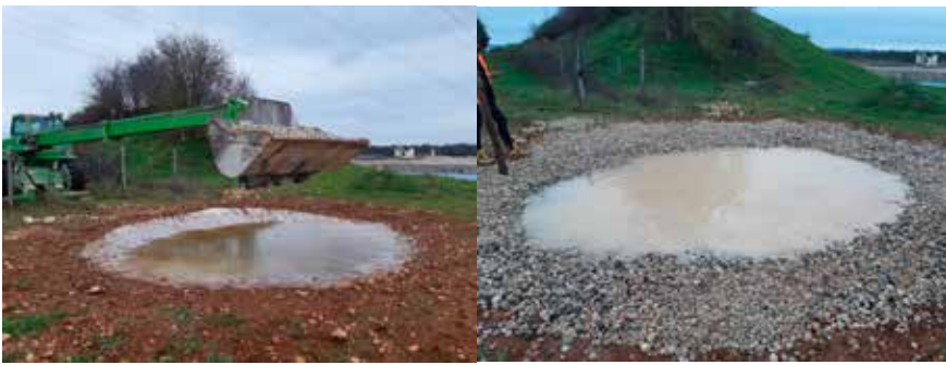
Création d'une mare à crapaud calamite
