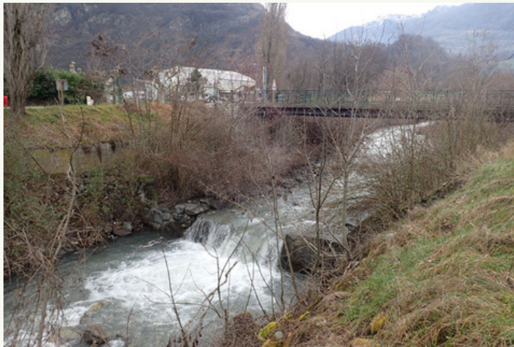
Seuil du pont de la Rizerie avant travaux
