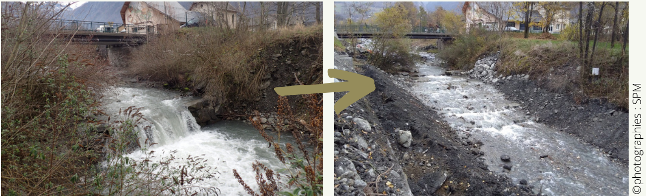
Seuil du pont de la Rizerie avant et après travaux
