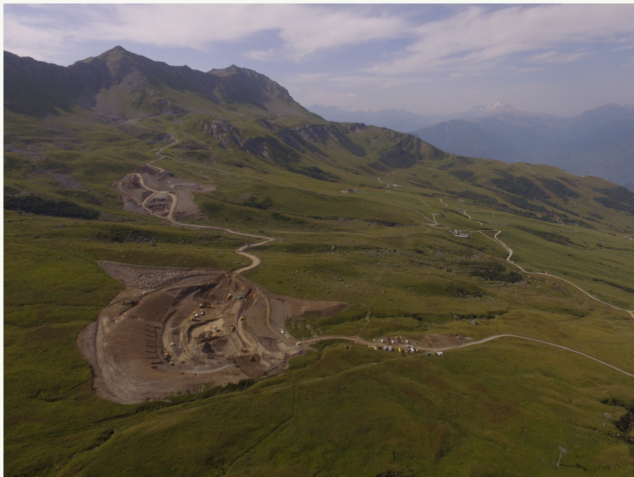
Travaux de la retenue des Platières
