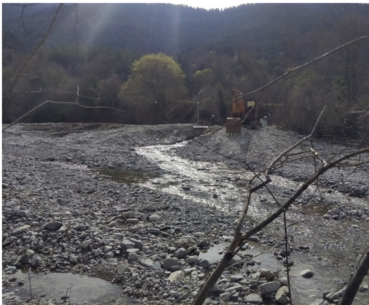
Travaux de curage sur l'Ébron
