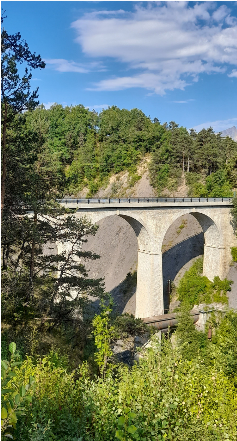
Le viaduc de Parassat, construit au XIXème siècle
