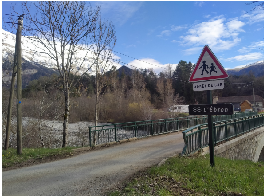
Le pont de Tréminis, qui traverse l'Ébron
