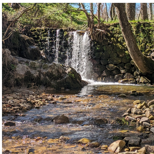
Ouvrage sur le Doux - SMBVD
