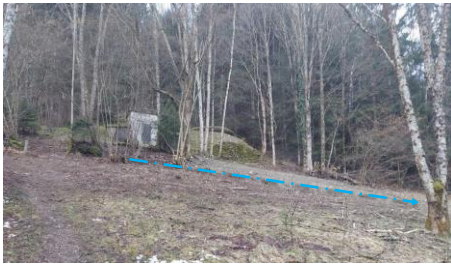
Vue depuis l'aval du réservoir (photo B Pilot) et simulation du projet de dérivation du trop plein
